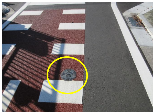
水道管仕切弁の蓋を小さい物に変更（2カ所）
